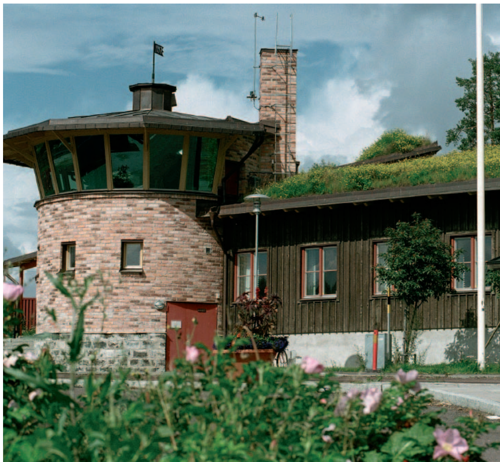
Vista del edificio de la empresa
